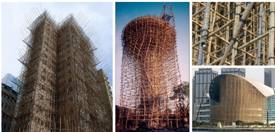
Рис. 1. Строительные леса из бамбука с различными формами
